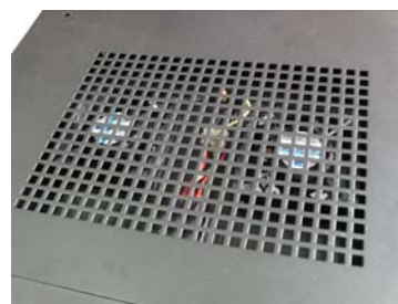
Ventilační jednotka instalovaná ve stropě rozvaděče, pohled shora přes krycí mřížku skříně
